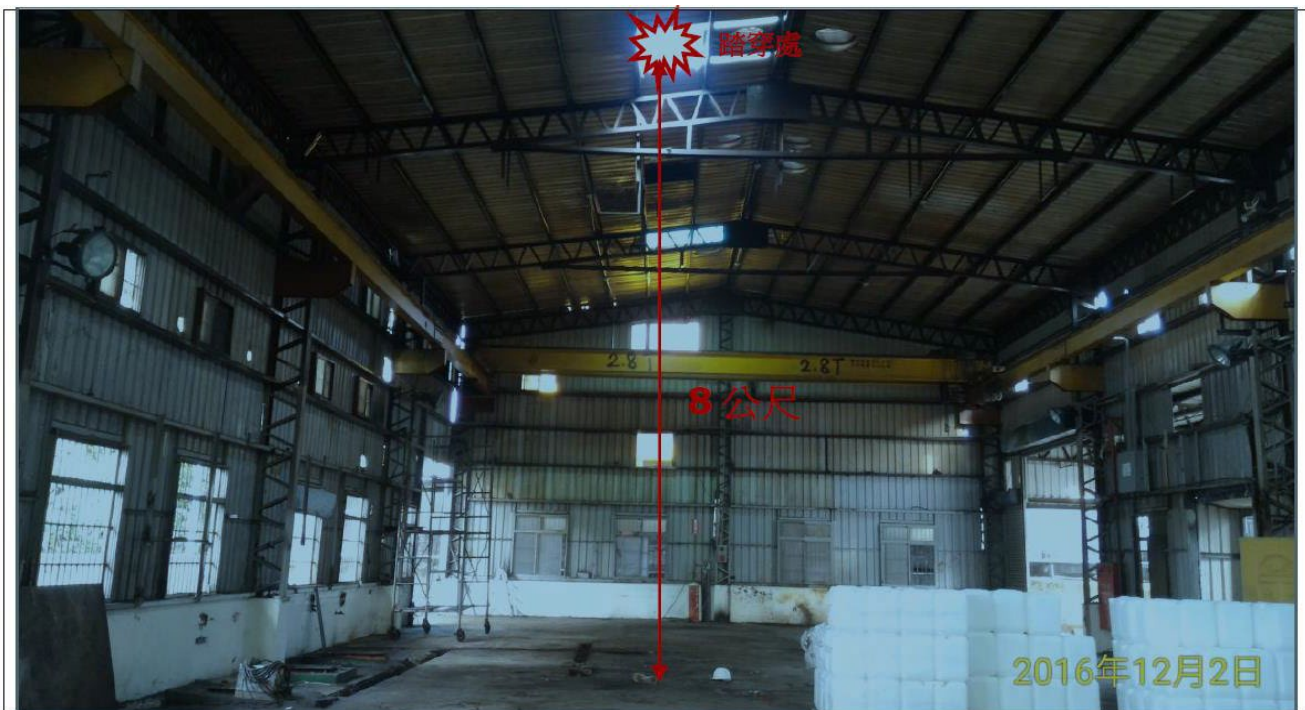
照片 1：災害發生是日進行屋頂修繕前測量工作
